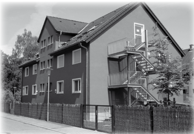
Nur 20 Jahre nach der Errichtung des ursprünglich für die Aufnahme von Asylbewerbern und Obdachlosen konzipierten Gebäudes wurden weitere 350.000 € in den Umbau zur KiTa investiert
